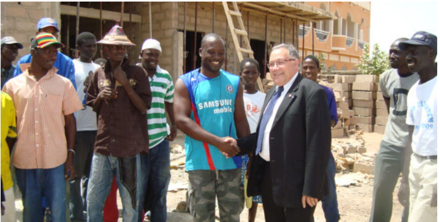
Construction d'un centre de documentation avec les jeunes de Kannel, région du Ferlo.
